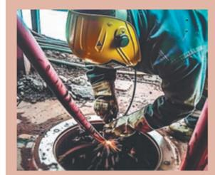
作业现场周围及下方的地面存在可燃物、空洞、客井、水封等情况时未落实检查分析、清扫封盖等可靠安全措施,对于作业现场周围有可能泄漏易燃、可燃物料的设备未落实隔绝措施的,不动火!
