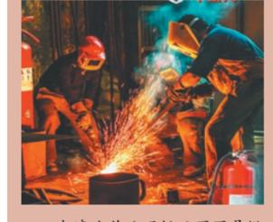
未清除作业现场及周围易燃物品或未落实安全有效防火措施的,作业现场未配备消防器材或配置的消防器材不能满足作业现场应急需求的,不动火!
