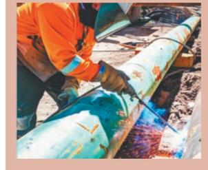
凡盛有或盛装过危险化学品的设备、管道等生产、储存设施未经清洗、置换并与生产系统彻底隔离的,不动火!
